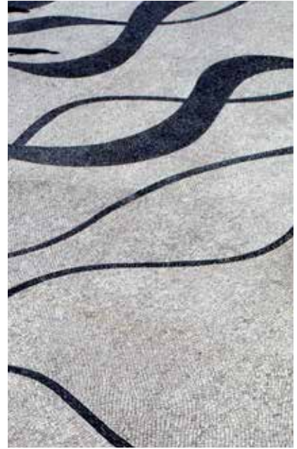
Fernando Conduto Sidewalk Mar Largo , 1998 ©Tiago Venâncio
