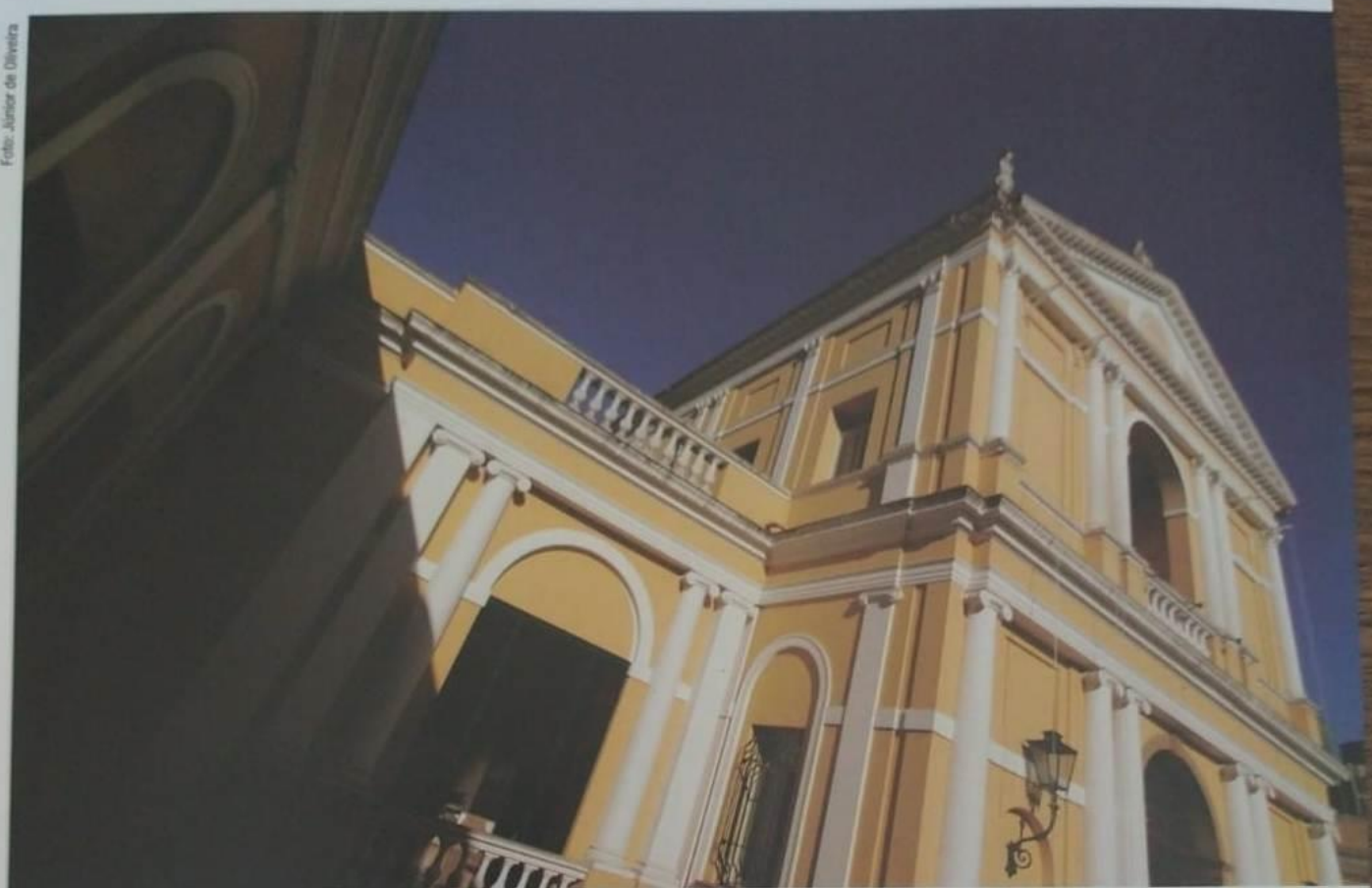
Fachada do Museu da Casa Brasileira em São Paulo
