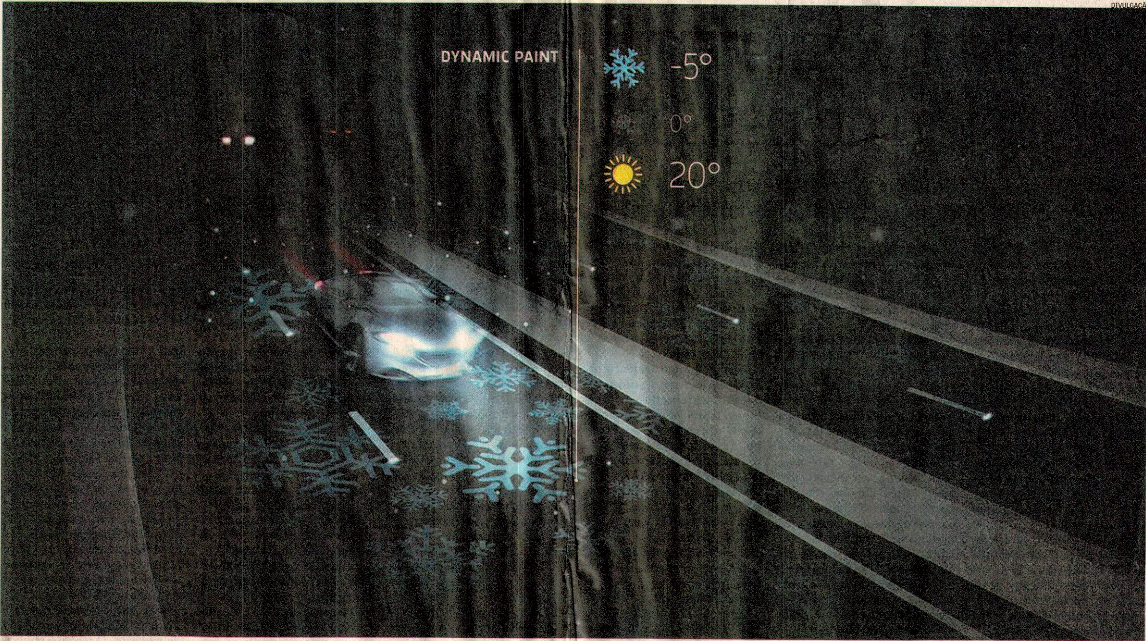
Smart Highway, projeto desenvolvido por uma equipe holandesa: pista com dispositivos inteligentes, tinta nas faixas centrais que se iluminam à noite e sinais de aviso aos motoristas que ligam automaticamente
