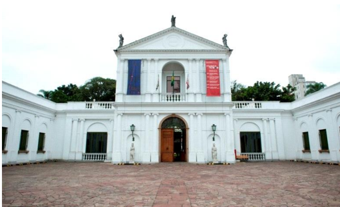
Fachada do Museu da Casa Brasileira na Avenida Faria Lima, em São Paulo.
